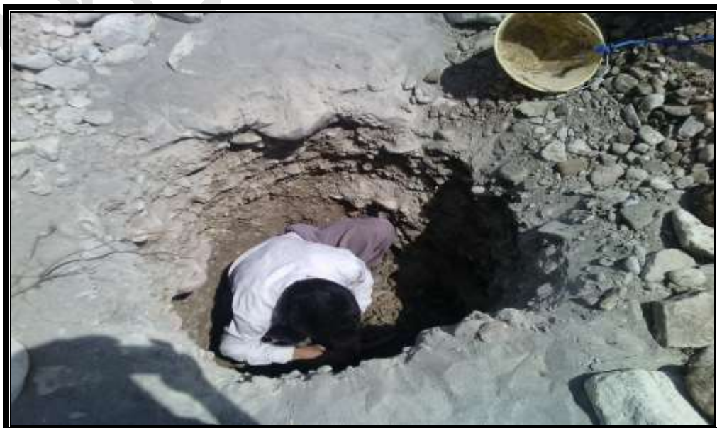
طرح سد رودبار لرستان - حفاری و نمونه برداری از ساحل رودخانه
