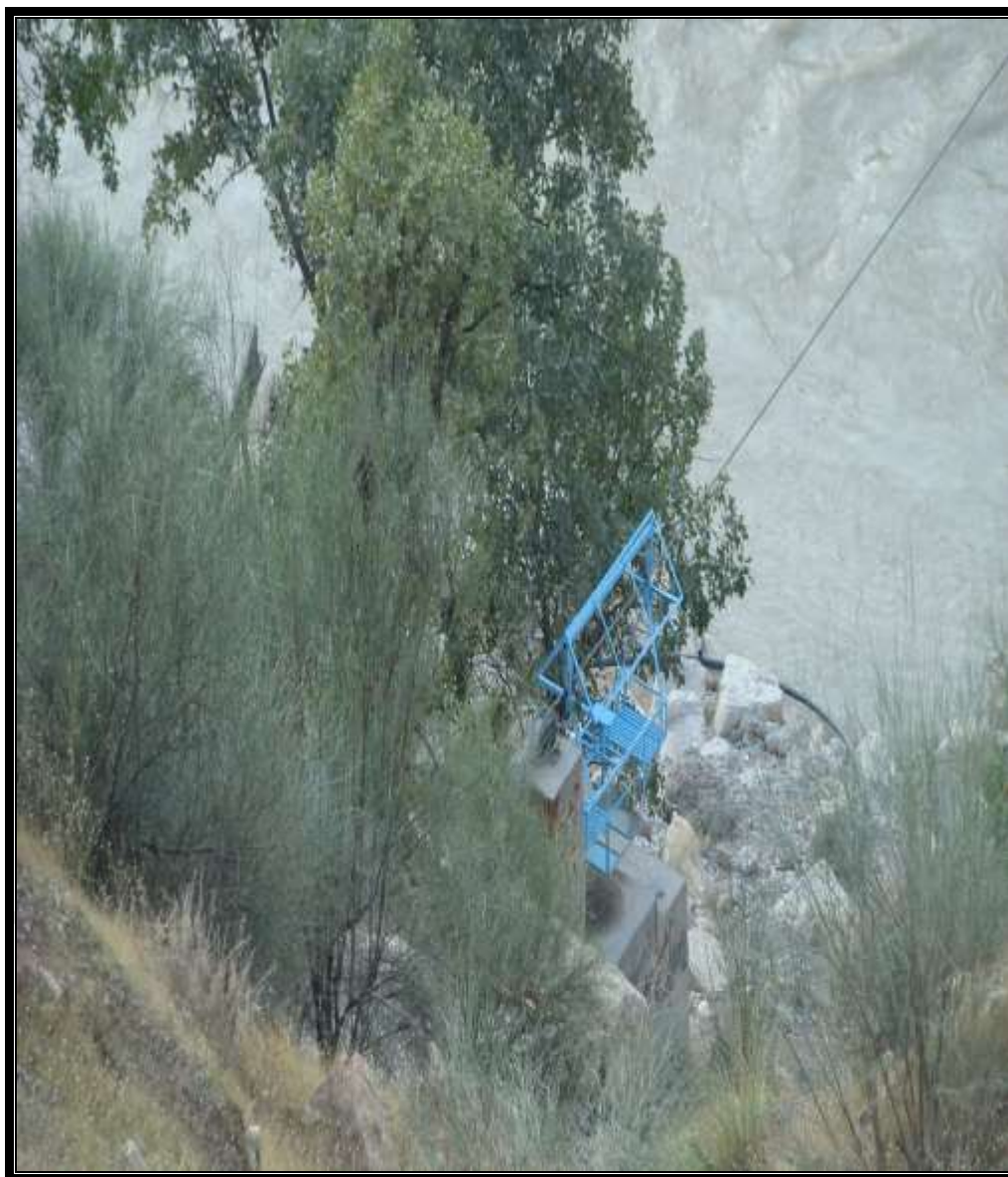
ایستگاه هیدرومتری درجه یک سد لپرو
